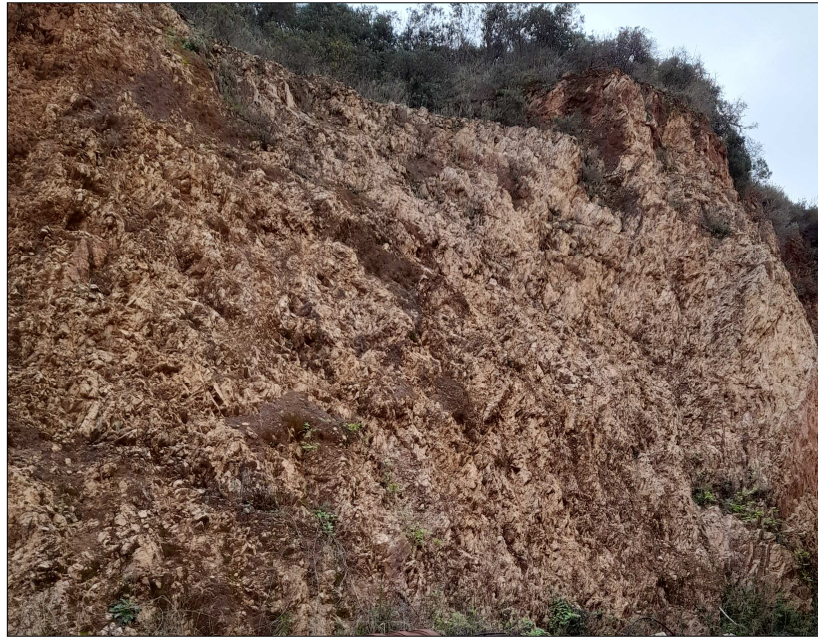
Foto 4 - Esempio di discontinuità dell'ammasso roccioso
